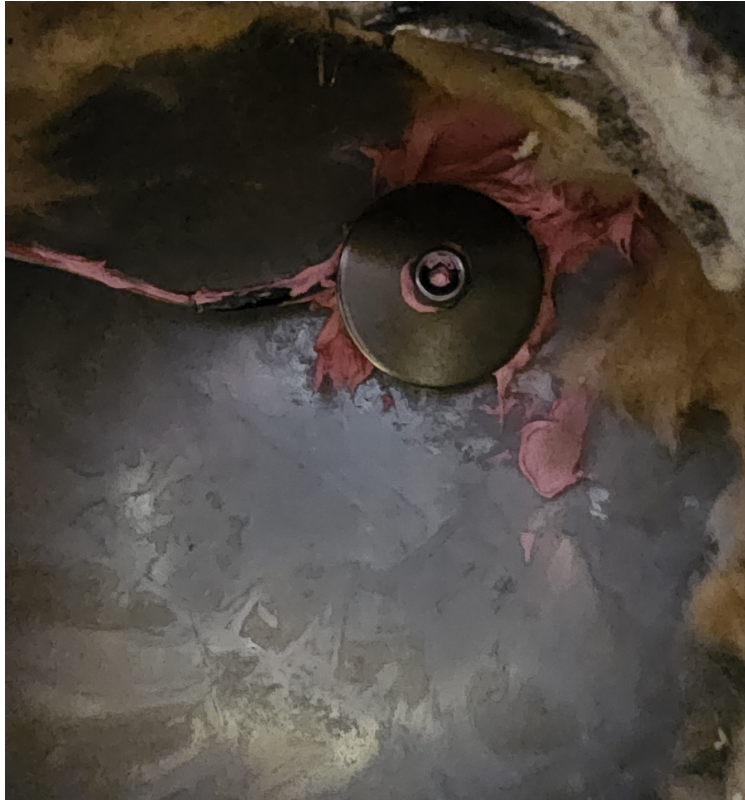
Sonde monteren met warmtegeleidingspasta
