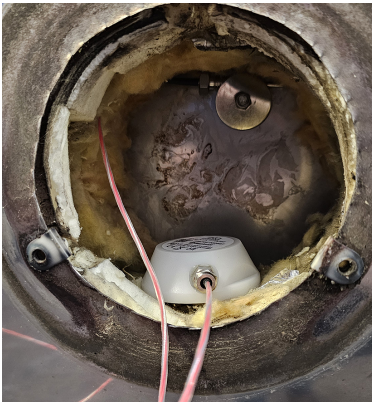
Sonde monteren met warmtegeleidingspasta
